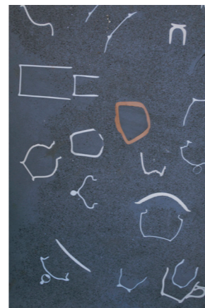
Gjenbruk av dekkesevise som et kreativt gjenbruksinnslag i støpt byromsflate på Vollebekk torg. Foto: Amund Johnne.
