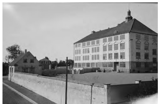
Sentrum skole sett fra Sentroveien, usikker datering, før 1950 (Foto: nb.no / Mittet & Co. AS)
