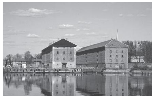
Figur 5.10: F.v.: Magasin B (inv.nr. 0129) og Magasin A (inv.nr. 0130), bygget hhv. 1839 og 1864, med mellomliggende kanal fra samme periode (foto hentet fra Verneplaner.no).
