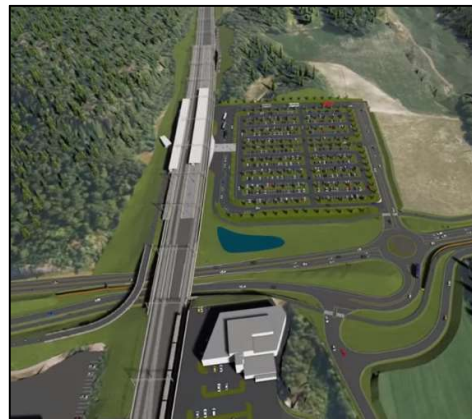
Nye Skoppum stasjon sett fra nord.
