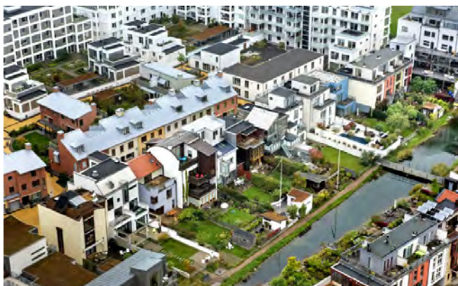
B001, MALMØ Variasjon i høyde, typologi og takutforming.
