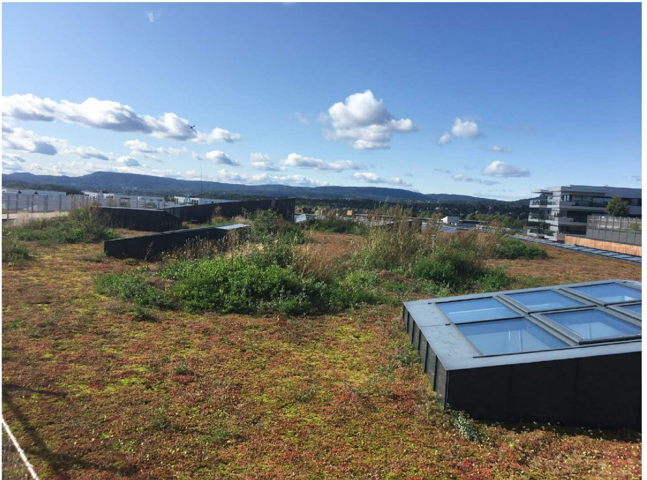
Figur 5-5. Grønt tak på Fornebu i Bærum. Her er det valgt en kombinasjon av Sedum-vegetasjon og felter med kalkrik tørrbakkevegetasjon som er basert på innsamlete frø fra nærområdet.
