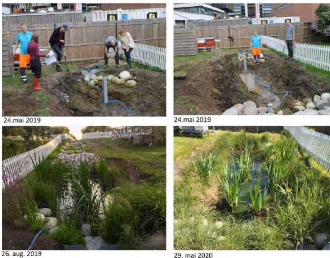
Figur 5-4 Etablering av terrassert regnbed og lommevåtmark. (Kilde: J.E. Colman, NaturRestaurering)
