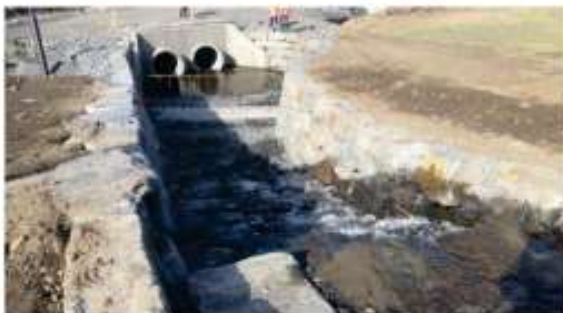
Figur 2.15. Vannveier skal håndtere dimensjonerende avrenning, hastighetsenergi og transport av sedimenter. EØ-prosjektet Hordorg (foto: T. Kval).
