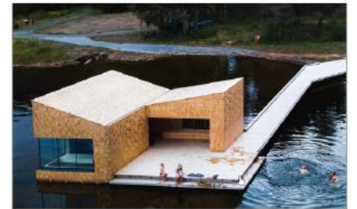
BANDAK, DALEN Badstu og badeanlegg
