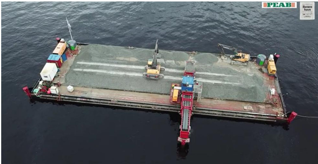
Figur 8: Tildeckingslekter Recto. Dette fartøyet ble brukt på broparten av tildeckingsarealene ved tildekking av forurenset sjøbunn i Indre havn Horten.
