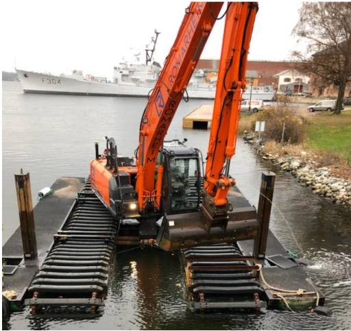
Figur 10: Tildeckingsutstyr «Waterking». Dette fartøyet ble brukt på de aller grunneste områdene ved tildekking av forurenset sjøbunn i Indre havn, Horten.
