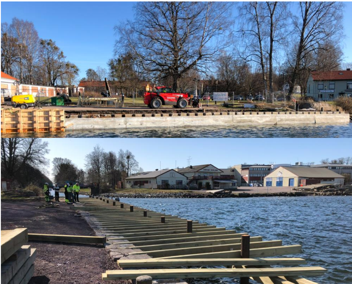
Figur 7: Øverst: Betongkonstruksjonen forsterkes med ny kappestøp som sees i front. Nederst: Ny trebrygge føres opp i tilnærmet med samme utførelse som den gamle trebryggen på Sykehusbrygga.
