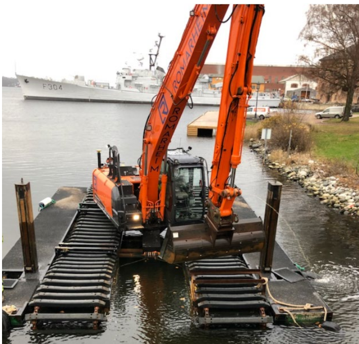
Figur 8: Tildeckingsutstyr Waterking. Dette fartøyet ble brukt på de aller grunneste områdene ved tildekking av forurenset sjøbunn i Indre havn, Horten.
