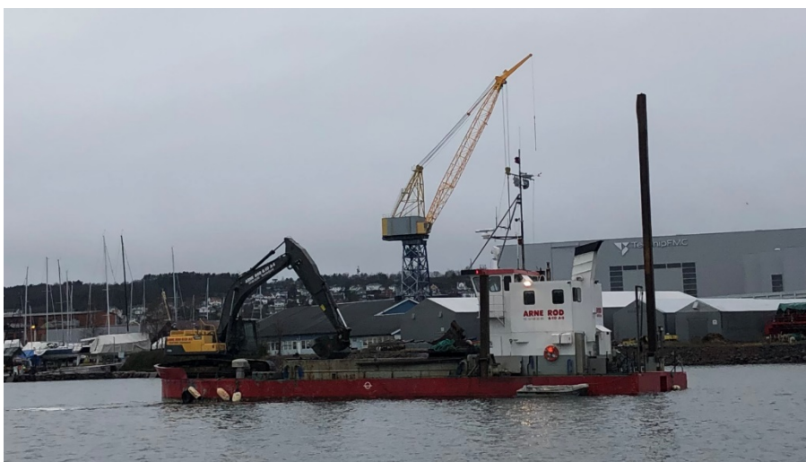
Figur 3: Mudringsfartøy Rødnes i Stjertebukt. Til venstre på fartøyet er gravemaskinen som ble brukt til gravingen.
