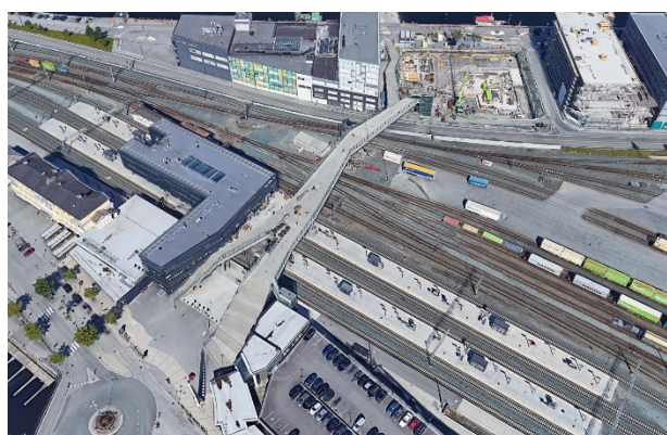
Figur 37: Sjøgangen over jernbanen på Brattøra i Trondheim. Foto: Google earth.
