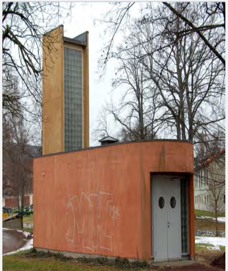
Pumpehuset sett fra sørvest.
