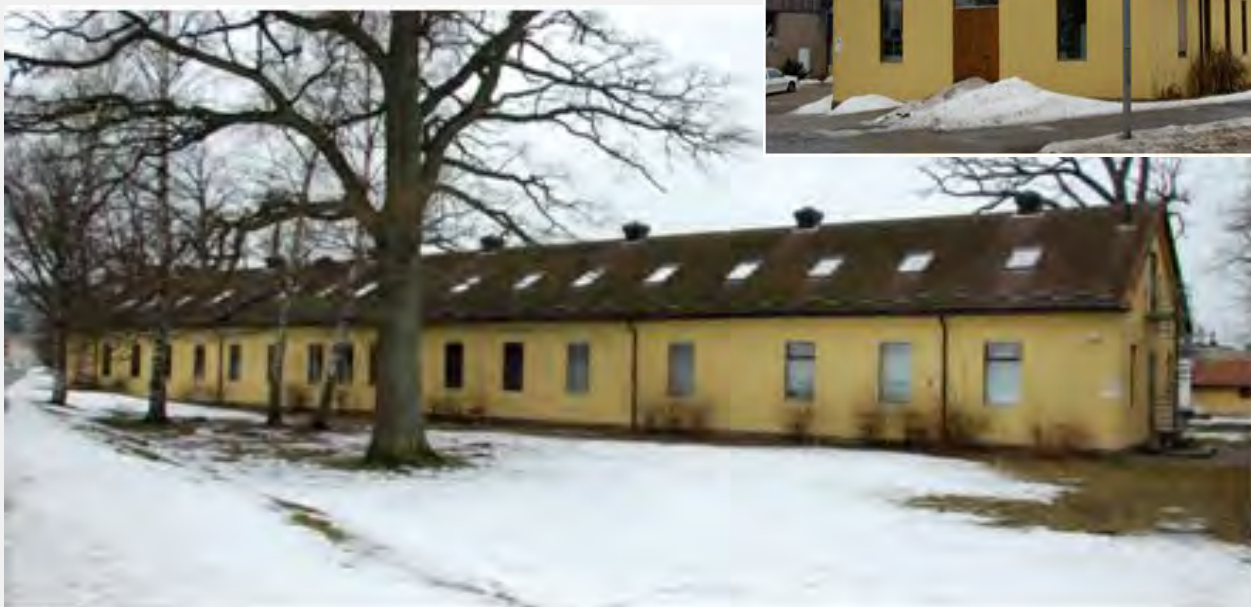
Horten Ressurscenter, Strandpromenaden 30.
