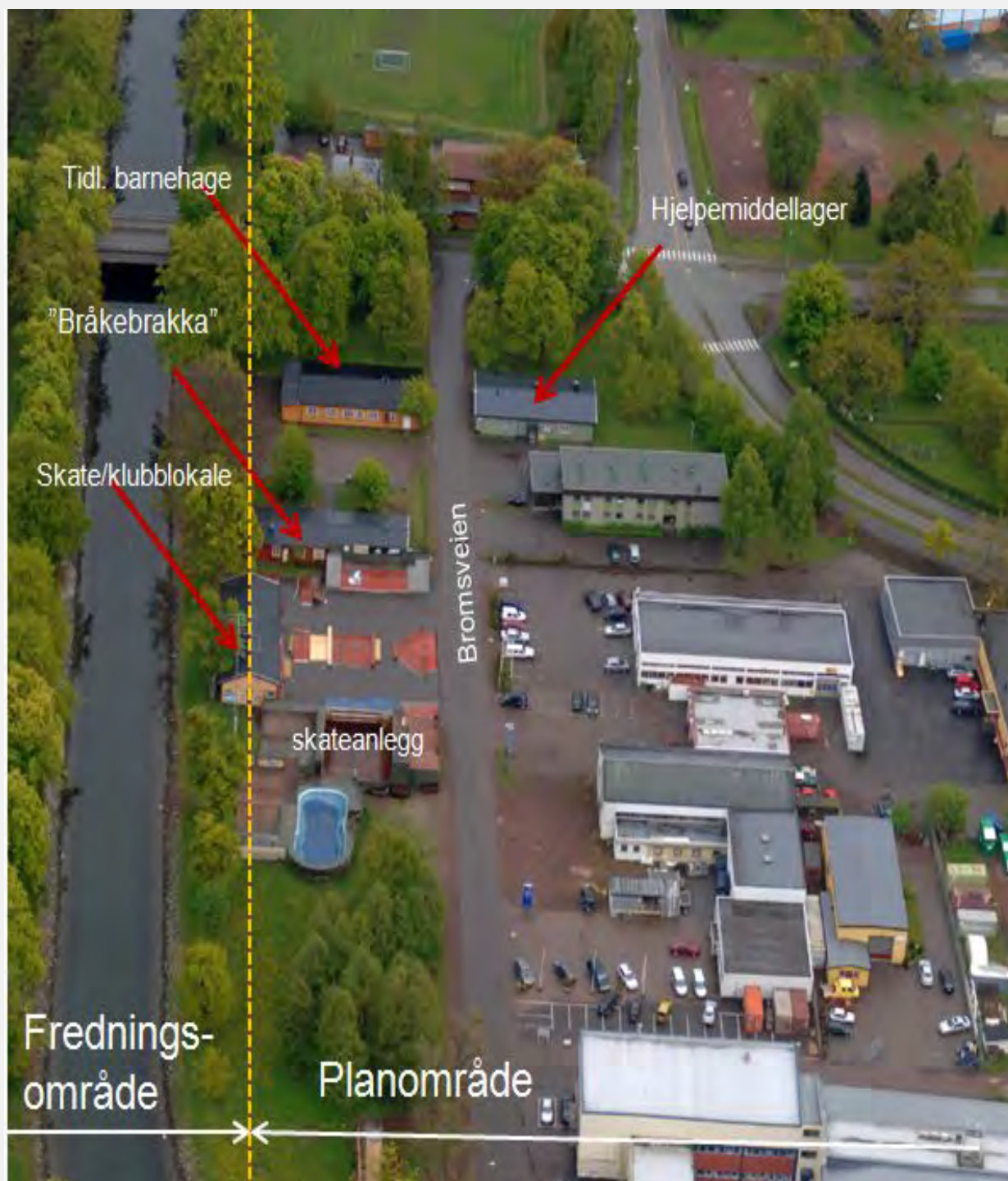
Oversiktsbilde tatt fra nord som viser tyskerbrakkene på begge sider av Bromsveien.
