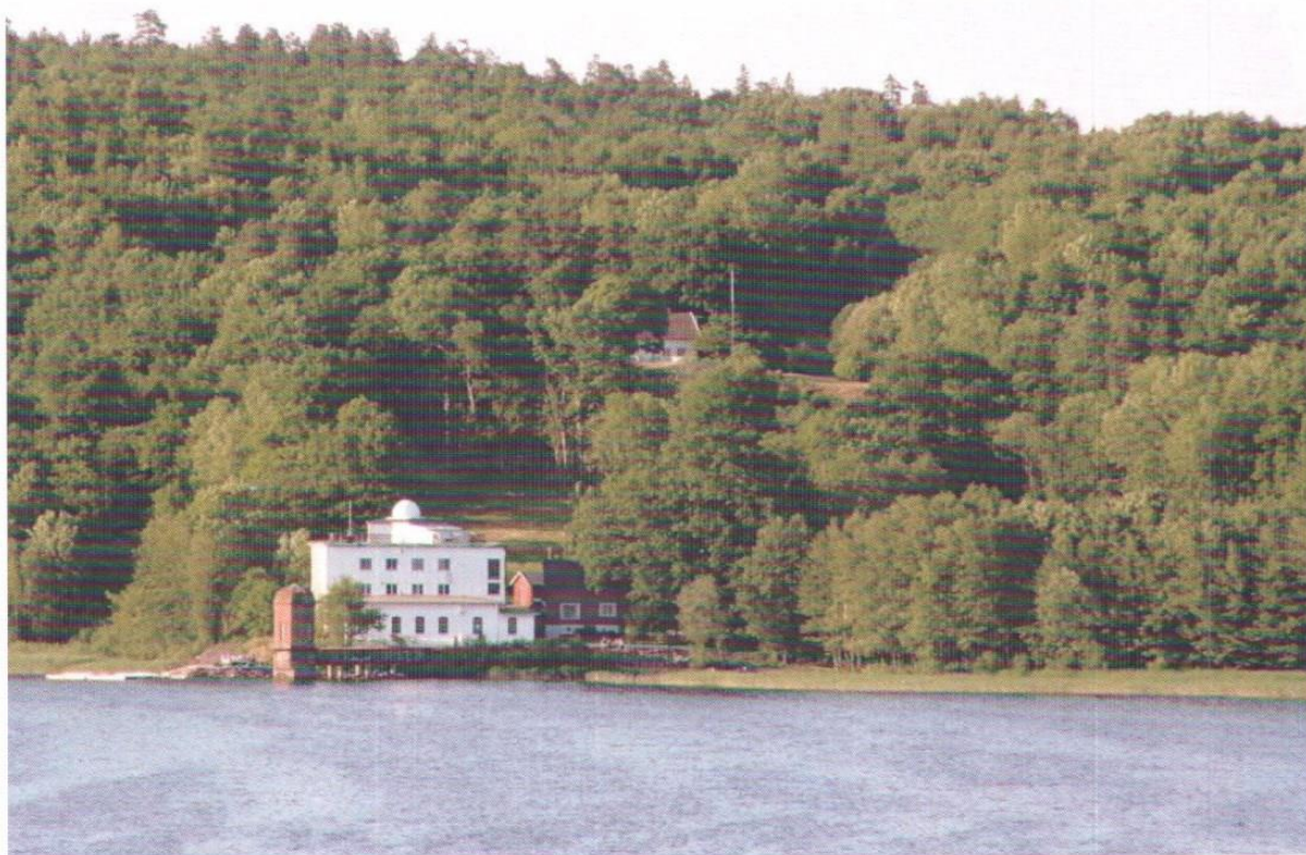
Figur 11: Bygningsmassen ved Knutsrød, som i dag brukes av Horten Natursenter, var pumpestasjon for Horten vannverk fra 1905 til 2006. Etter 1975 har Borrevannet kun fungert som reservedrikkevannskilde, og driften har vært minimal (foto: O.K. Spikkeland).
