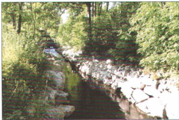
Figur 6: Utløpskanalen fra Borrevannet leder fram mot demningen ved Øvremølla. Demningen regulerer nivået til Borrevannet (foto: O. K. Spikkeland).
