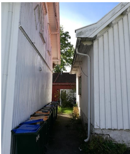
Bilde 3 og 4: Eksempel på søppeldunker plassert i rømningsvei tett opp mot brennbar yttervegg og lett tilgjengelig.
