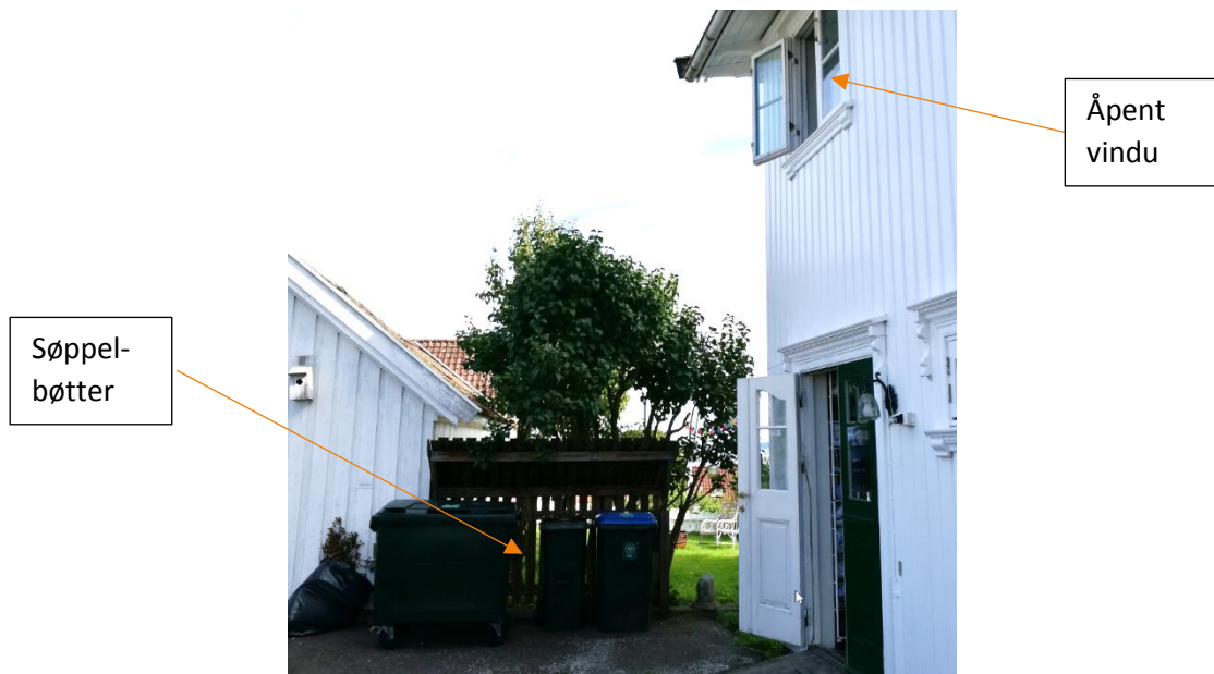
Bilde 2: Eksempel på sannsynlig brannspredning via søppelkasser.
