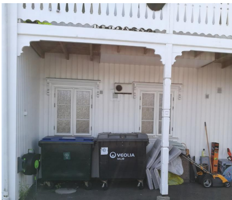
Bilde 3 og 4: Eksempel på søppeldunker plassert i rømningsvei tett opp mot brennbar yttervegg og lett tilgjengelig.
