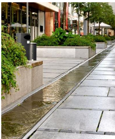
Figur 40 Vannrenne i granitt med forslag til 'overgang'. Bilder fra Jogra.
