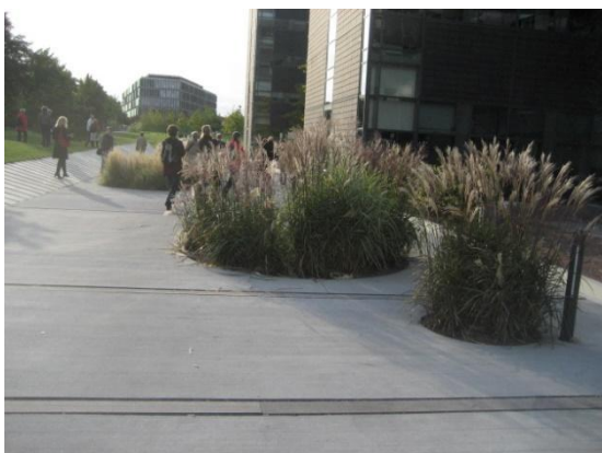
Figur 2 Betongdekke med utsparinger til prydgress. Fredriksberg, Danmark
