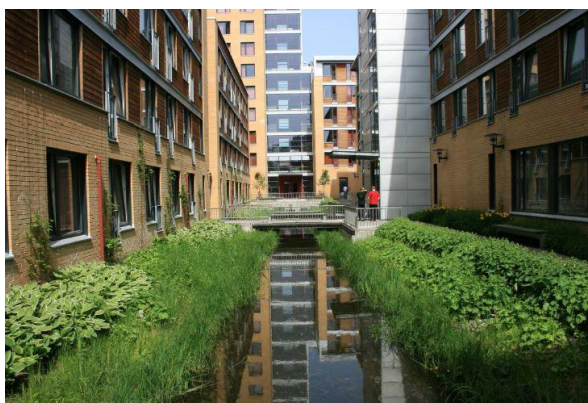
Figur 29 Eksempel på fordrøyningsdam. Bjølsen studentby Oslo. Foto: Rainer Stange/ Dronninga landskap
