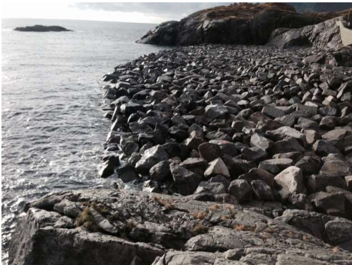
Figur 3 Eksempel på bølgedempende fylling i strandkanten fra E10 ved Reine i Lofoten.
