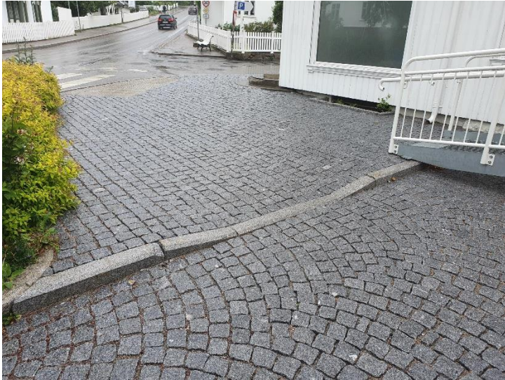
Figur 14 Dekke med brostein er en dårlig løsning for blinde og rullestolbrukere. Redusert kontrastfarger mellom brostein og kantstein gjør det vanskelig for svaksynte å se høydeforskjellen i dette eksempelet, slik at det kan være en reell snublefare.
