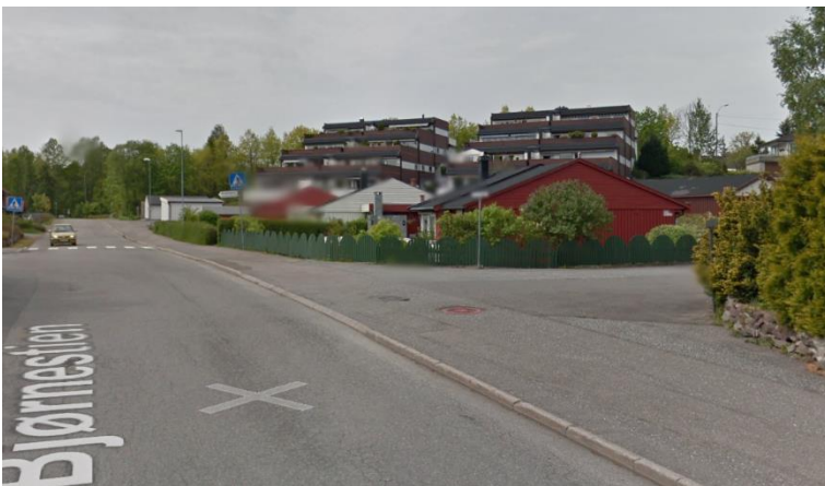
Figur 9 viser krysset mellom Bjørnestien og Beverstien før kryssutbedringene. (bilde fra google maps)
