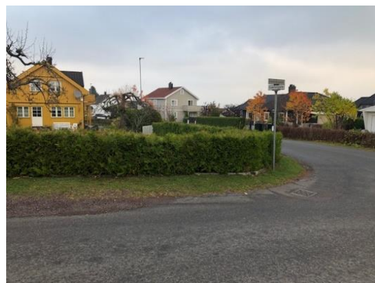
Figur 12 viser krysset etter at hekken er klippet ned. Sikten er betraktelig bedre.
